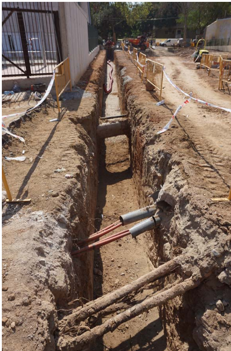
Fig.39 Detall de la rasa per a la construcció de serveis I
