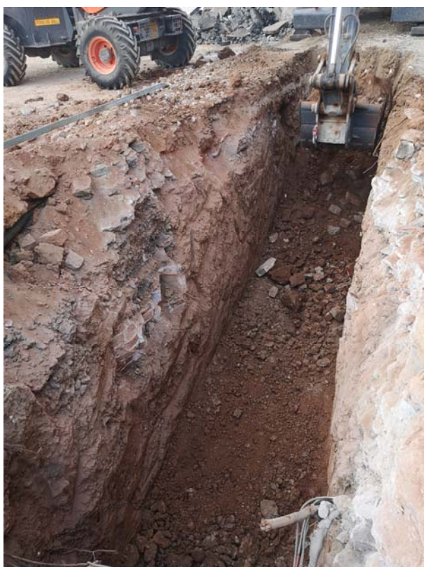
Fig.40 Detall del procés de rebaix de la rasa per a la construcció de serveis II
