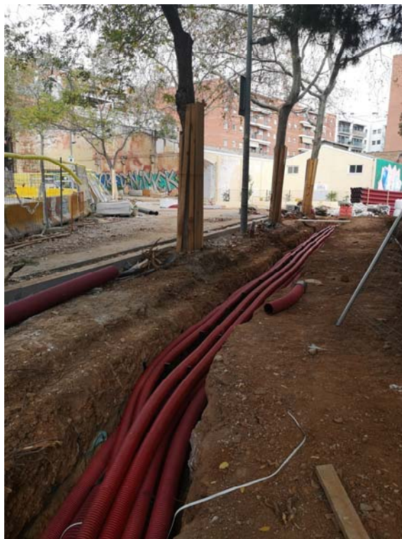
Fig.4 Detall de la rasa II amb el pas del servei de llum.
