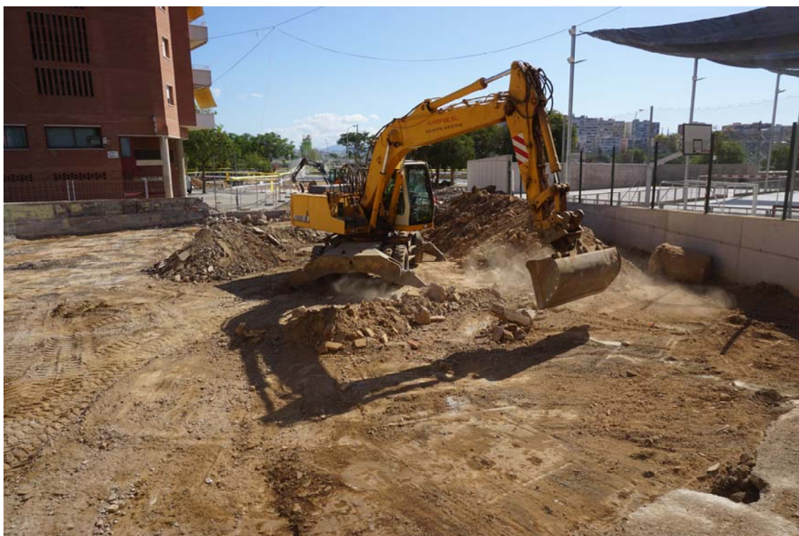
Fig.19 Detall de les feines de rebaix de la superfície del sector II. Des del sud.
