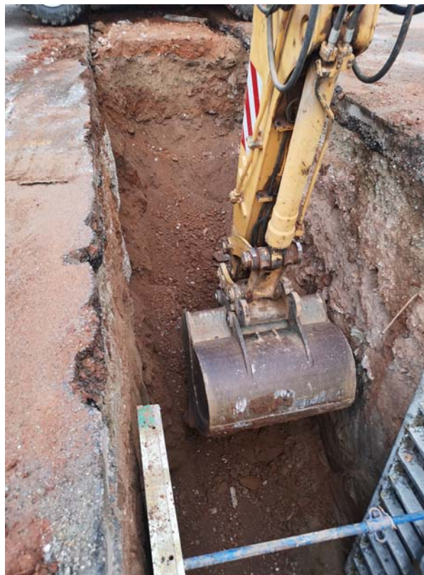
Fig.63 Detall del procés de desmuntatge de l'estructura negativa UE 114
