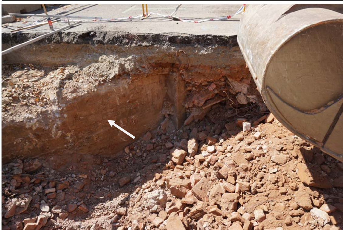
Fig.6 Detall del mur de formigó, UE 117 , de l'edifici de la Valls Sistach i la runa del propi edifici que es va fer servir per regularitzar aquest punt.
