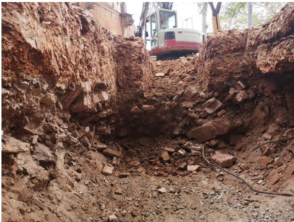
Fig.3 Detall de la rasa I i de l'arqueta pel pas de serveis en aquest punt. S'aprecia perfectament l'estratigrafia i el nivell de runa de l'edifici Valls-Sistach.
