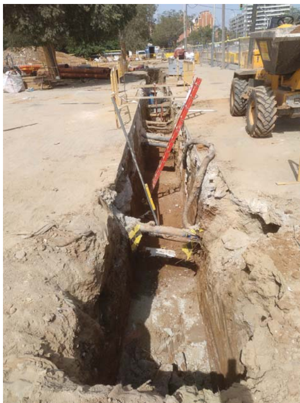
Fig.41 Detall de la rasa per a la construcció de serveis III. Des del sud.
