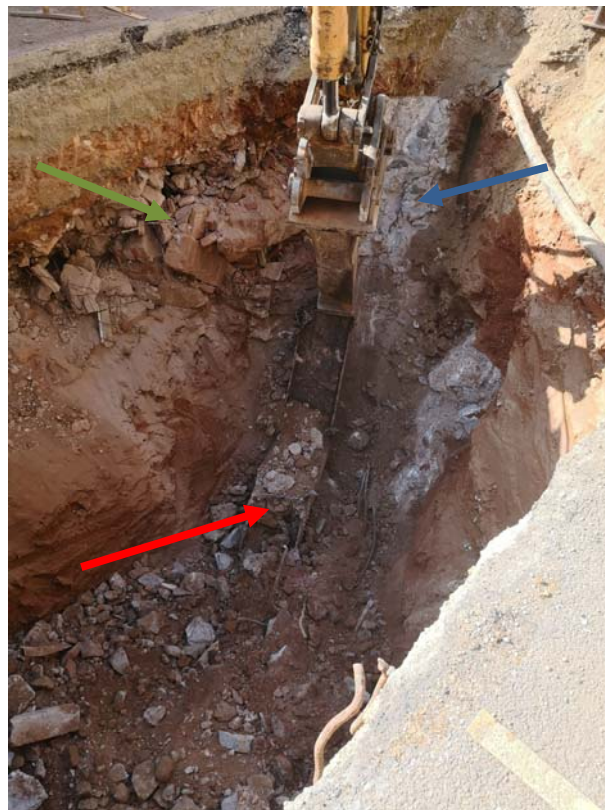
Fig.9 Fletxa verda, runa de l'edifici. Fletxa vermella, pilar de ferro de la nau industrial Valls-Sistach i fletxa blava mur de l'edifici Valls-Sistach.
