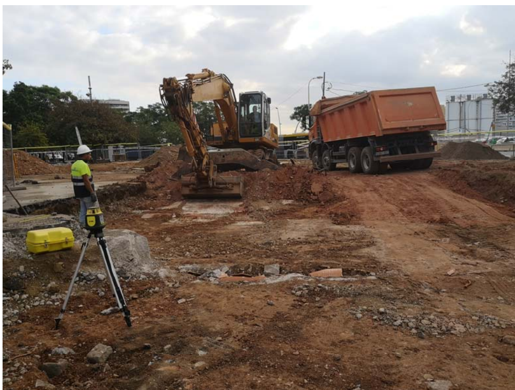
Fig.37 Detall del procés de rebaix amb màquina de la part nord del sector III.
