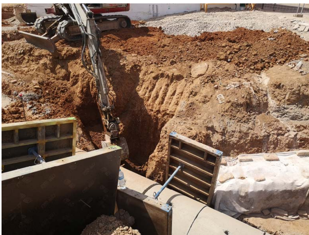
Fig.24 Detall del procés de rebaix de la rasa IV.
