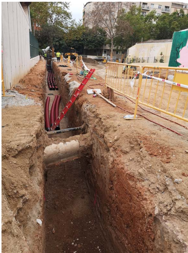
Fig.22 Detall de la rasa II per la construcció de serveis.
