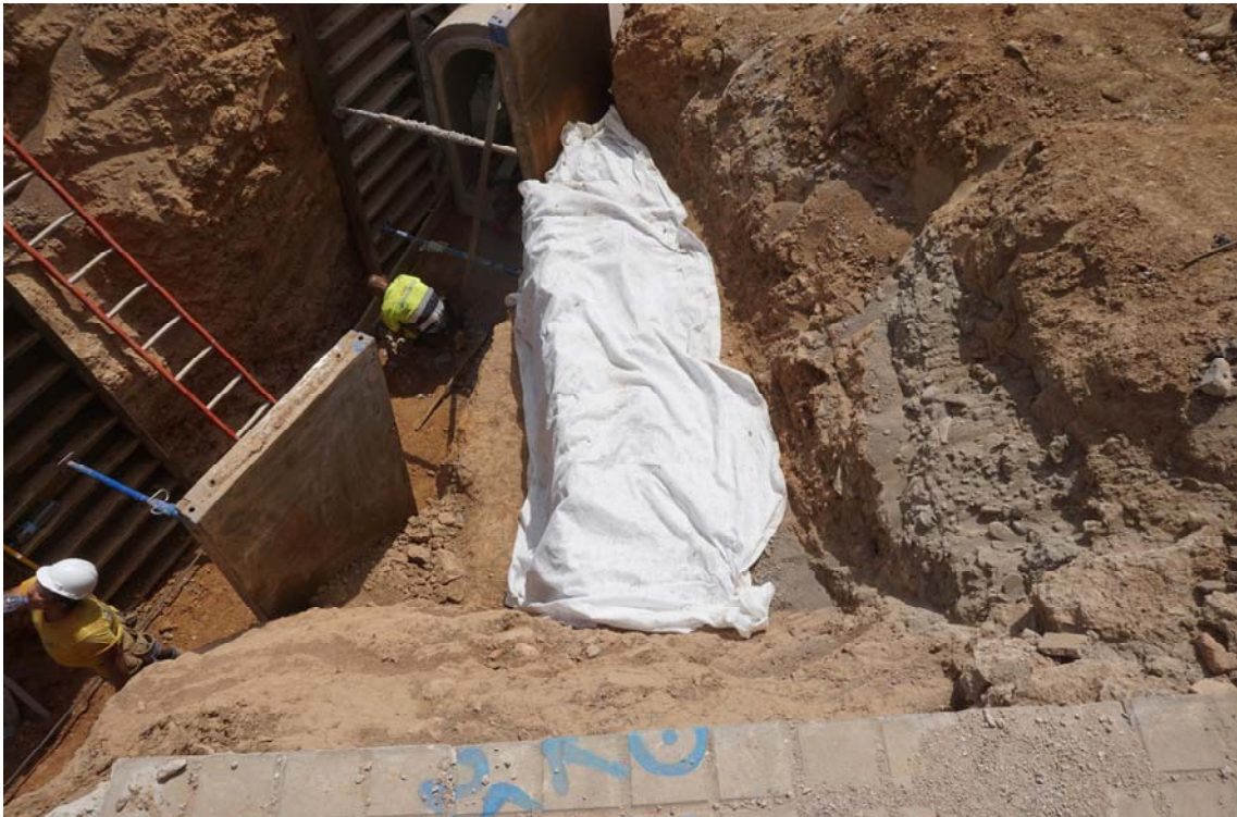
Fig.66 Detall de la protecció amb geotèxtil del mur UE 212
